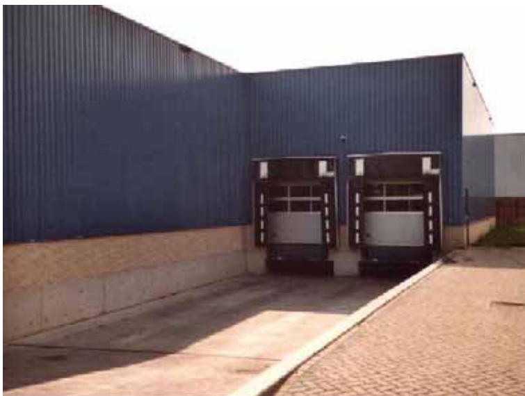
Dubbele laadput voor een loods
